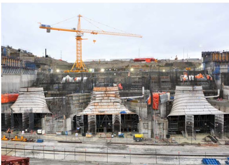
Izq: Central J. Céspedes: vista de los tubos de aspiración de las tres turbinas. Der: Tubo de aspiración de una de las turbinas de la represa JC.
