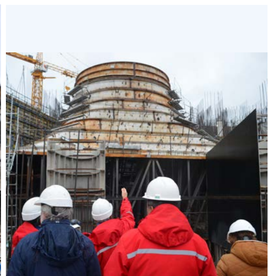
Izq: Central J. Céspedes: vista de los tubos de aspiración de las tres turbinas. Der: Tubo de aspiración de una de las turbinas de la represa JC.
